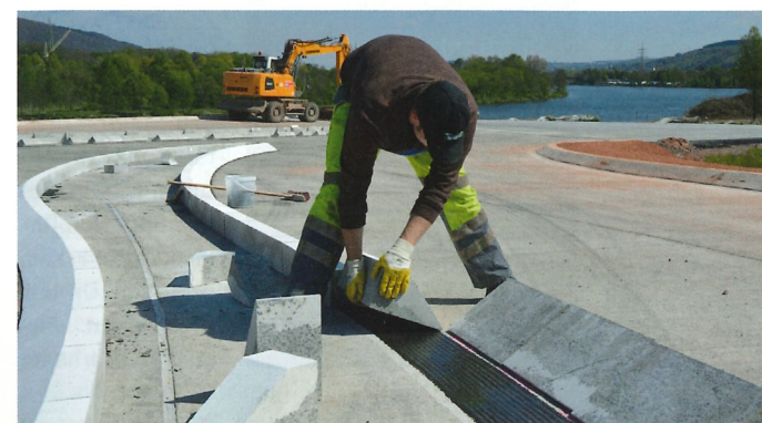
Bild 1: In einem Dünnbettklebverfahren wird 2-K-Kunststoff auf der mit Wasserhochdruck gereinigten Betonplatte aufgebracht und die Flachborde mit der geschnittenen Seite verklebt. Ist der Kleber aufgebracht, werden die Steine einfach nur umgekippt und etwas ausgerichtet. (Fotos: Hermann MEUDT Betonsteinwerk GmbH)
