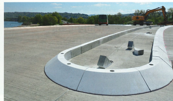
Bild 2: In den Radiensteinen sind die Bohrungen für die noch einzubringenden Glasmarker gut zu erkennen. Sie sorgen bei Dunkelheit für eine gute Verkehrsleitwirkung
